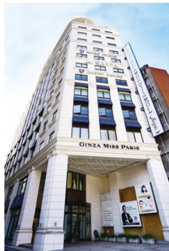
銀座4丁目交差点にほど近い晴海通り沿いのミス・パリ本社ビル
